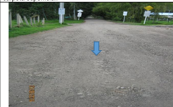
Foto 4: Panorámica del segmento vial que de acuerdo a la imagen presenta la pérdida del material de fresado en la carpeta superficial.
