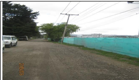
Foto 1: De acuerdo a la imagen se evidencia la ausencia de material de fresados o el tratamiento superficial doble.
