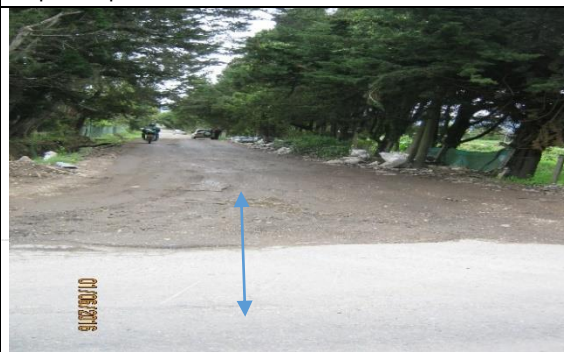
Foto 2: Panorámica del segmento vial que de acuerdo a la imagen presenta la pérdida del material de fresado en la carpeta superficial.
